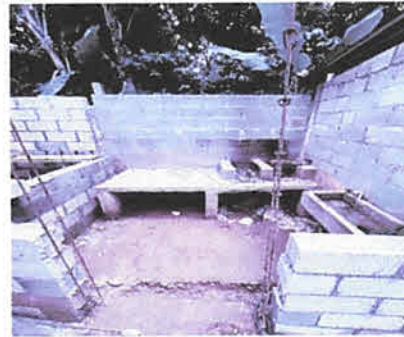
FOTO 4: Ampliacion de Cocina
