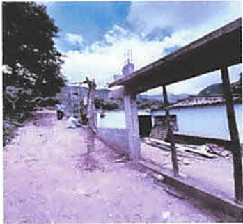
FOTO 3: Sustrucion de muro
