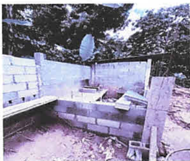
FOTO 5: Ampliacion de Cocina
