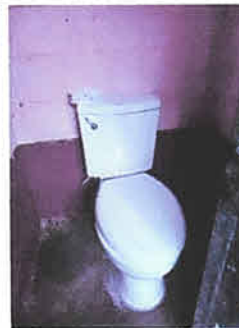
FOTO 6: Sustrucion de 2 Sanitarios
